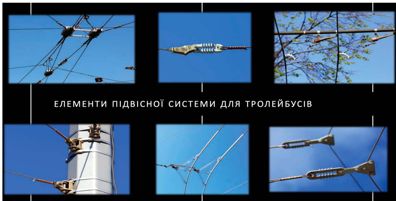
Рис. 2.3. Елементи підвісної мережі для тролейбусів виробництва компанії «Elektroline»
