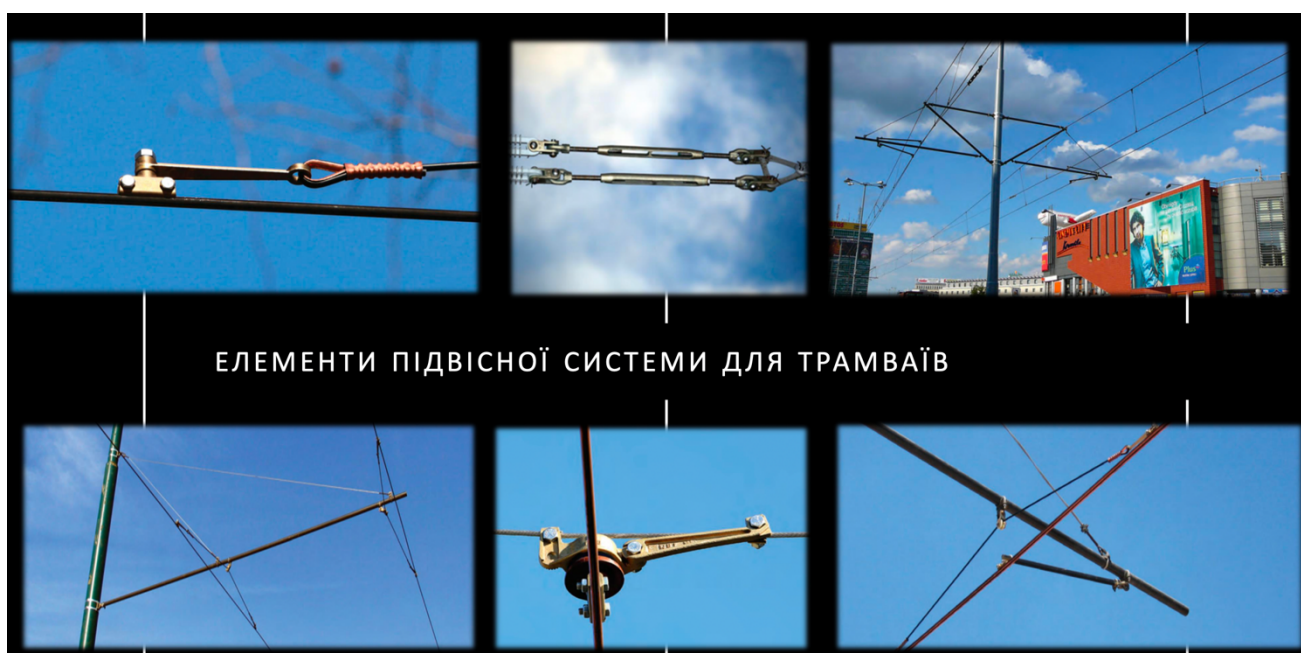
Рис. 2.3. Елементи підвісної мережі для тролейбусів виробництва компанії «Elektroline»
