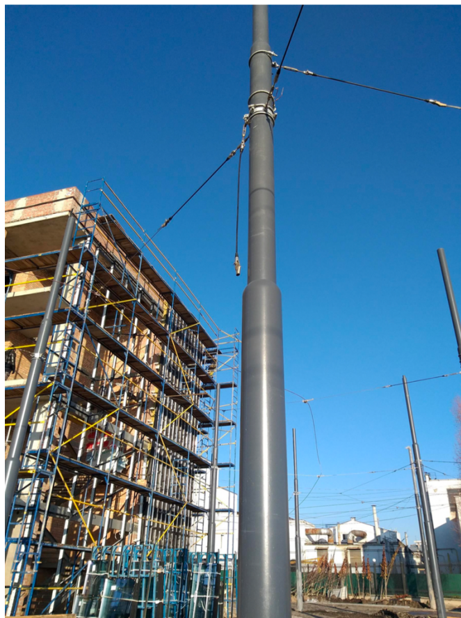
Рис 2.1. Опора контактної мережі виробництва «ELV» типу TSR.
