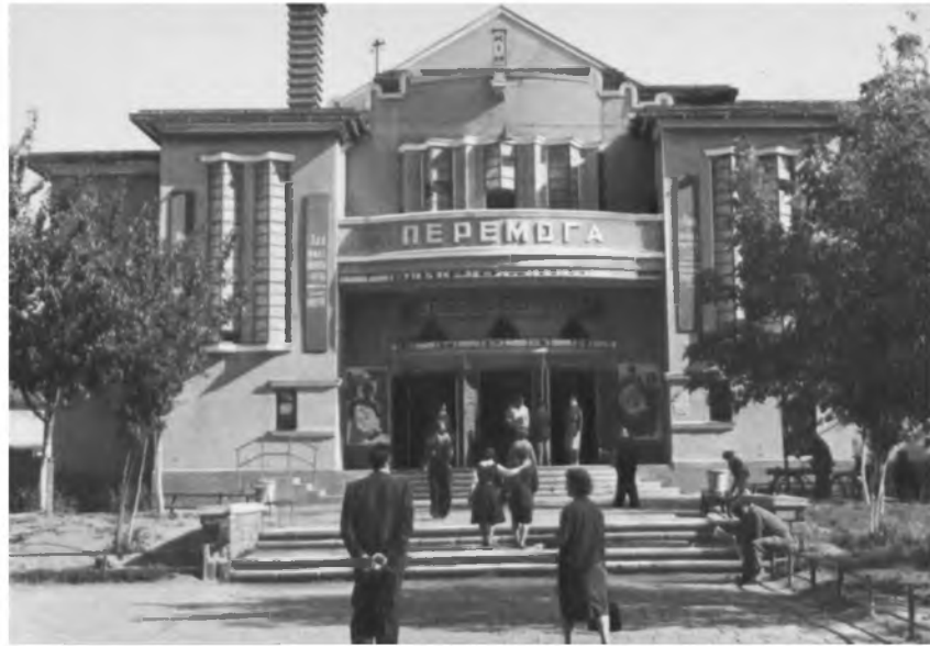
Будівля кінотеатру «Перемога» в Мукачеві, де проходив Перший з'їзд Народних комітетів Закарпатської України 417
