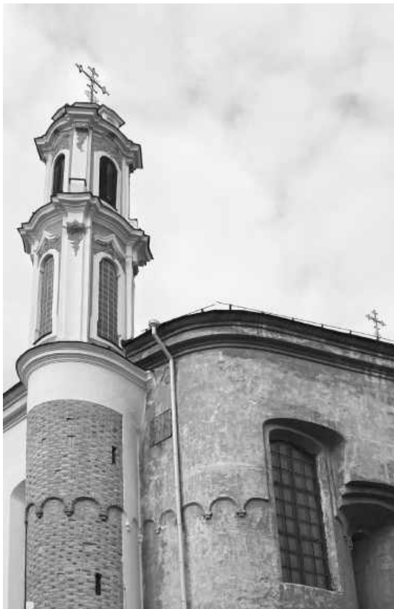
Відкриття елементів давньої кладки й оздоблення вежі храму Пресв. Трійці у Вільнюсі після реставраційних робіт 2016–2017 рр. Фотограф Сальвіюс Кулявічюс, 2017 р.
